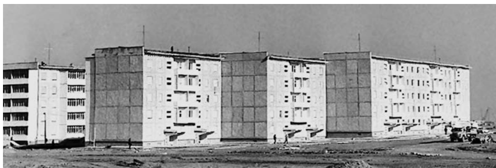
Крупнопанельные «пятиэтажки». Ташауз. 1985 г.
