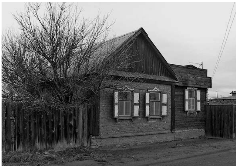
Туркмены Астраханской области. Жилой дом в селе Фунтово 2. 2010 г. Фото С. Габбасова
