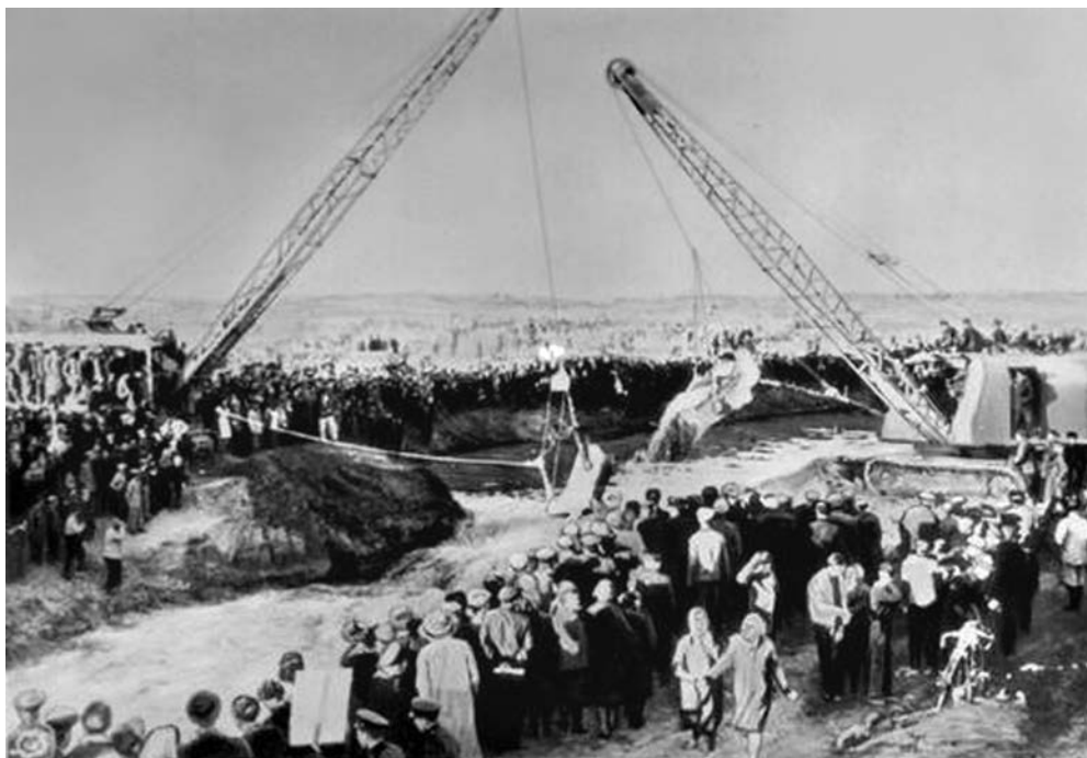
Строительство второй очереди Каракумского канала. 1960 г. (по: БСЭ – http://dic.academic.ru/dic.nsf/bse/ )
