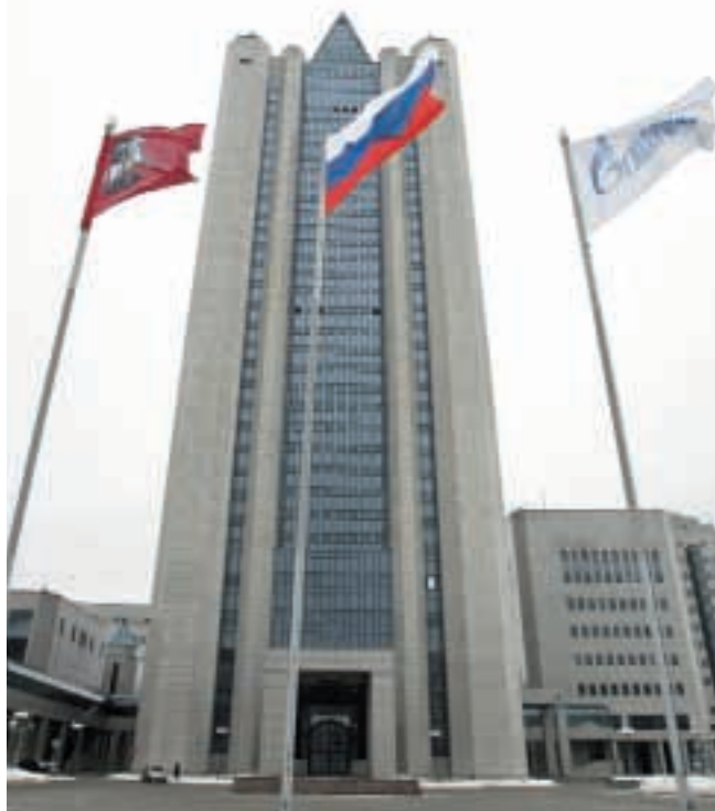
Почему всемогущий российский Газпром, являясь собственником трубопроводов, отказался от прибыльного бизнеса в пользу никому неизвестных компаний? AFP/Yuri Kadobnov
